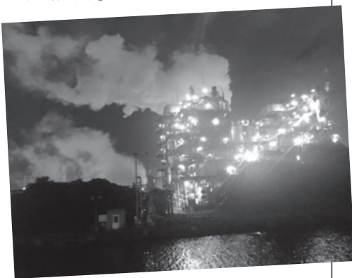
蒸気が上がる「昭和電工川崎事業所」
